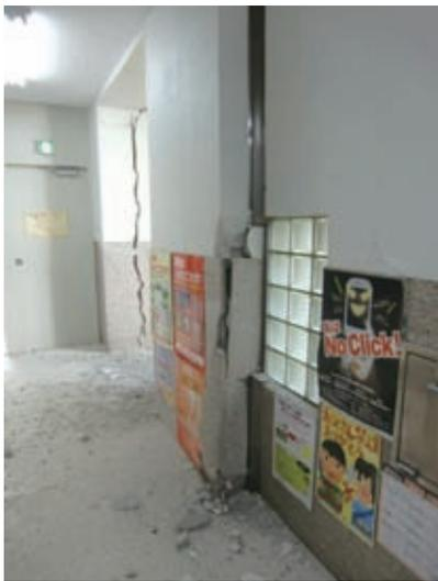
図3 2年生教室前の廊下と柱の亀裂
