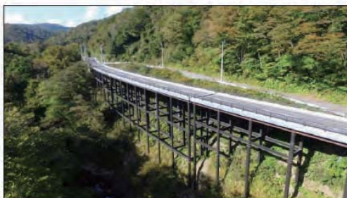
通年通行化された国道347号(加美町)
